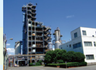
昭和電工(株)ガス化プラント (昭和電工(株)提供)
